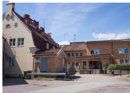
Foto av den äldre delen av Tallgården i gul puts tillsammans med den senare bygganden från 90-talet i rött tegel.
