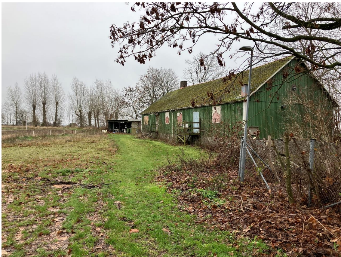
Figur 5. Foto på befintliga byggnader från platsbesök 2022-12-07.
