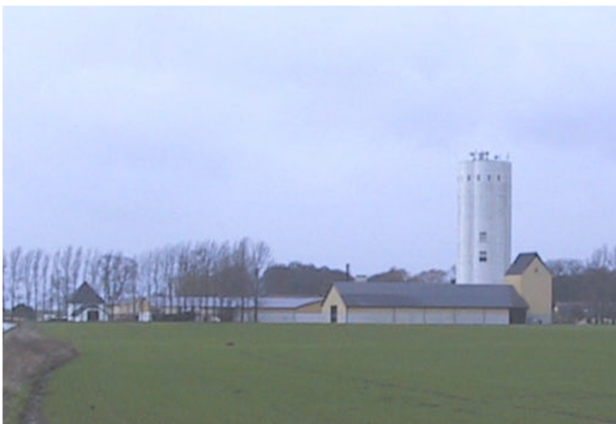
Vy över godsområdet. Det stora silotornet tillvänster med sin originellt veckade fasad.
