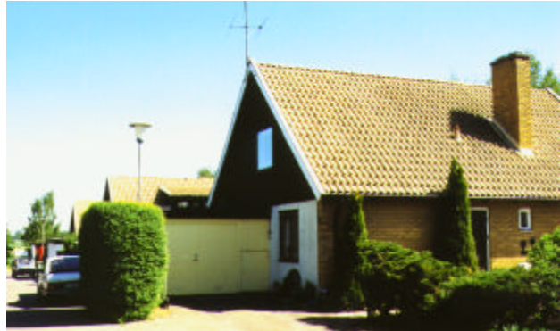
Kedjehusområdet vid Stinsvägen
